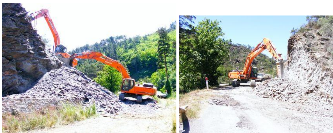
Les travaux du Conseil Général sur la Départementale 983
