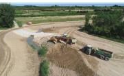
Travaux de suppression de digues défilantes et renaturation du Briançon à Théziers (ci-dessus) - Prélèvement réalisé dans le cadre d'une étude sur les eaux souterraines (ci-contre)
